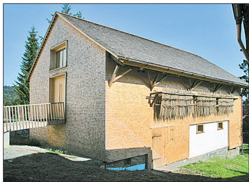
„Messmer Stall“ in Alberschwende wurde mit dem Holzbaupreis für vorbildliche Sanierung ausgezeichnet. (Foto: Ruff)
